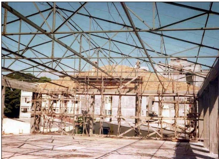
Fotografia 14 – Segundo pavimento (Auditório) com a estrutura metálica da cobertura
